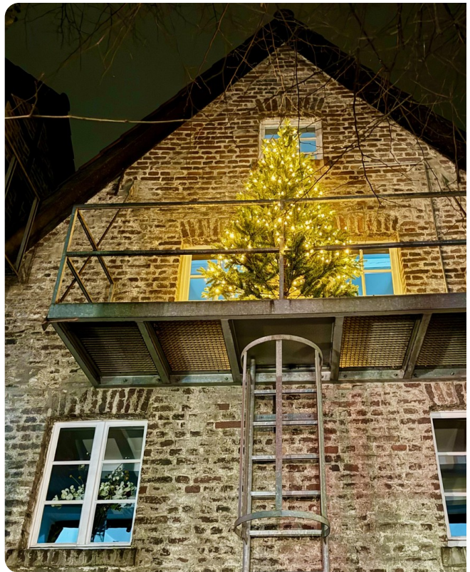
Giebelseite mit Fluchtbalkon
